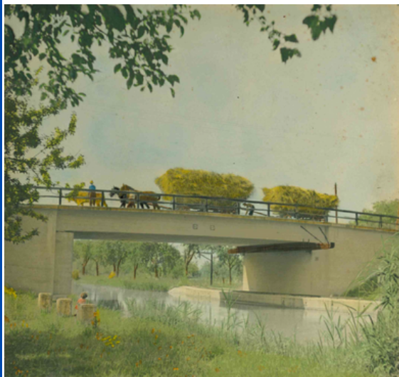
Le pont du Canal
