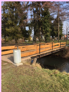
Le pont vers l'APP a été consolidé avec des traverses et une rambarde en chêne et celui vers l'école a bénéficié d'un nouvel habillage au sol pour la sécurité des piétons.
