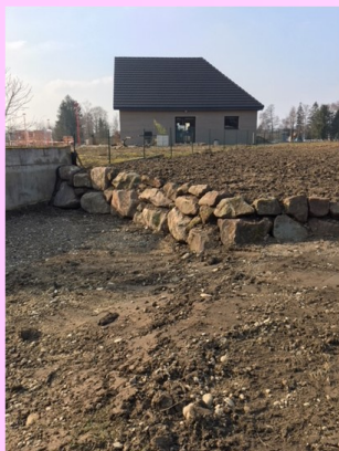
La place à l'arrière de la rue Lucie Berger a été stabilisée par un enrochement.
