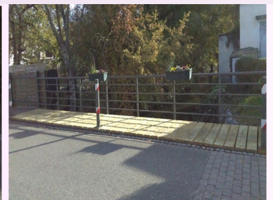
Le pont vers l'APP a été consolidé avec des traverses et une rambarde en chêne et celui vers l'école a bénéficié d'un nouvel habillage au sol pour la sécurité des piétons.
