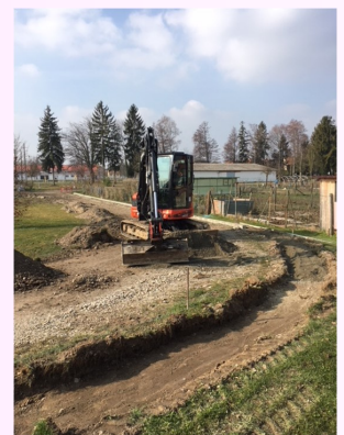
Le chemin menant à l'APP et aux jardins communaux a été refait afin d'éviter que l'eau de pluie ne s'écoule dans les jardins.
