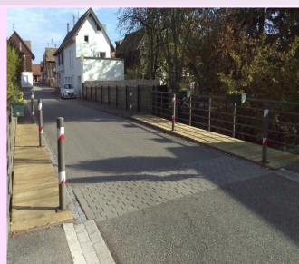
Le pont vers l'APP a été consolidé avec des traverses et une rambarde en chêne et celui vers l'école a bénéficié d'un nouvel habillage au sol pour la sécurité des piétons.
