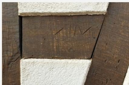
Chaque pièce de la charpente était numérotée en chiffres romains pour faciliter le montage. Avant la construction définitive, des essais étaient faits soit sur la place du village, soit sur un étalon à échelle réelle. Il était donc possible de transporter la structure pour déplacer la maison.
